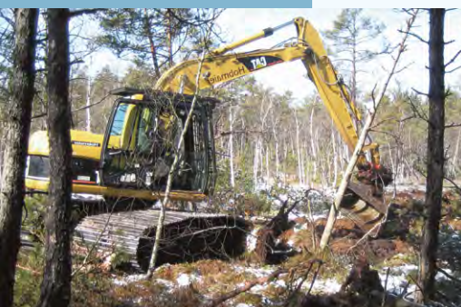
Entwässerungsgräben werden mit Torf verfüllt – der entscheidende Schritt zur Renaturierung .
